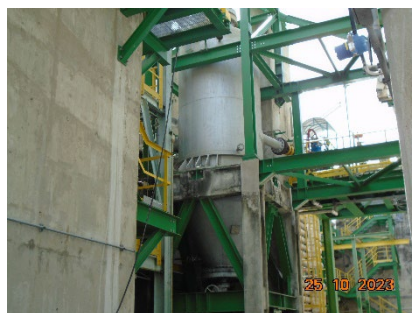
ภาพที่ 2-6 Emergency Venting Systems (EVS)
