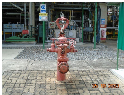
ภาพที่ 2-34 Three-Way Valve (Fixed Monitor)
