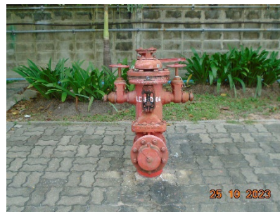
ภาพที่ 2-38 ระบบหัวฉีดดับเพลิงแบบ 2 ทาง
