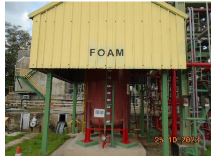
ภาพที่ 2-48 Foam Bladder Tank
