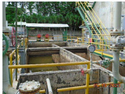
ภาพที่ 2-16 API Separator
